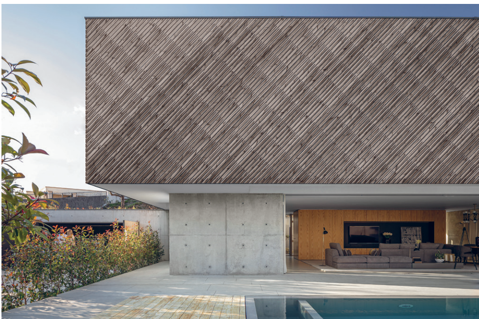
■ Dùm A, Portugalsko. REM'A Arquitectos. Fotografie: Studio Ivo Tavares
