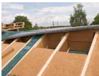
Pohled do izolační roviny střešní konstrukce. Předem izolované nosníky STEICO joist s izolací STEICO flex .
