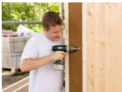
Upevnění nosníků STEICO wall pomocí vrutů přes zadní pásnici.
